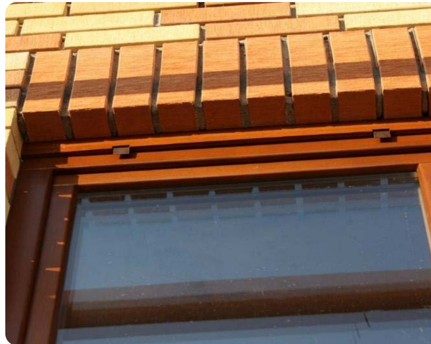
Внешний вид кладки с использованием закладных деталей BRICKO
