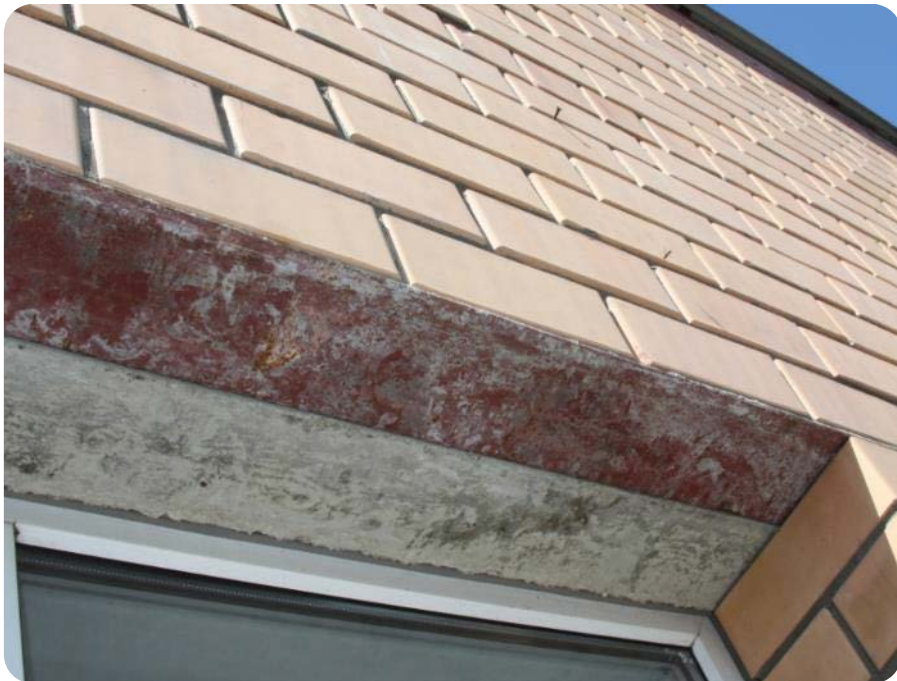
Внешний вид кладки без использования закладных деталей BRICKO
